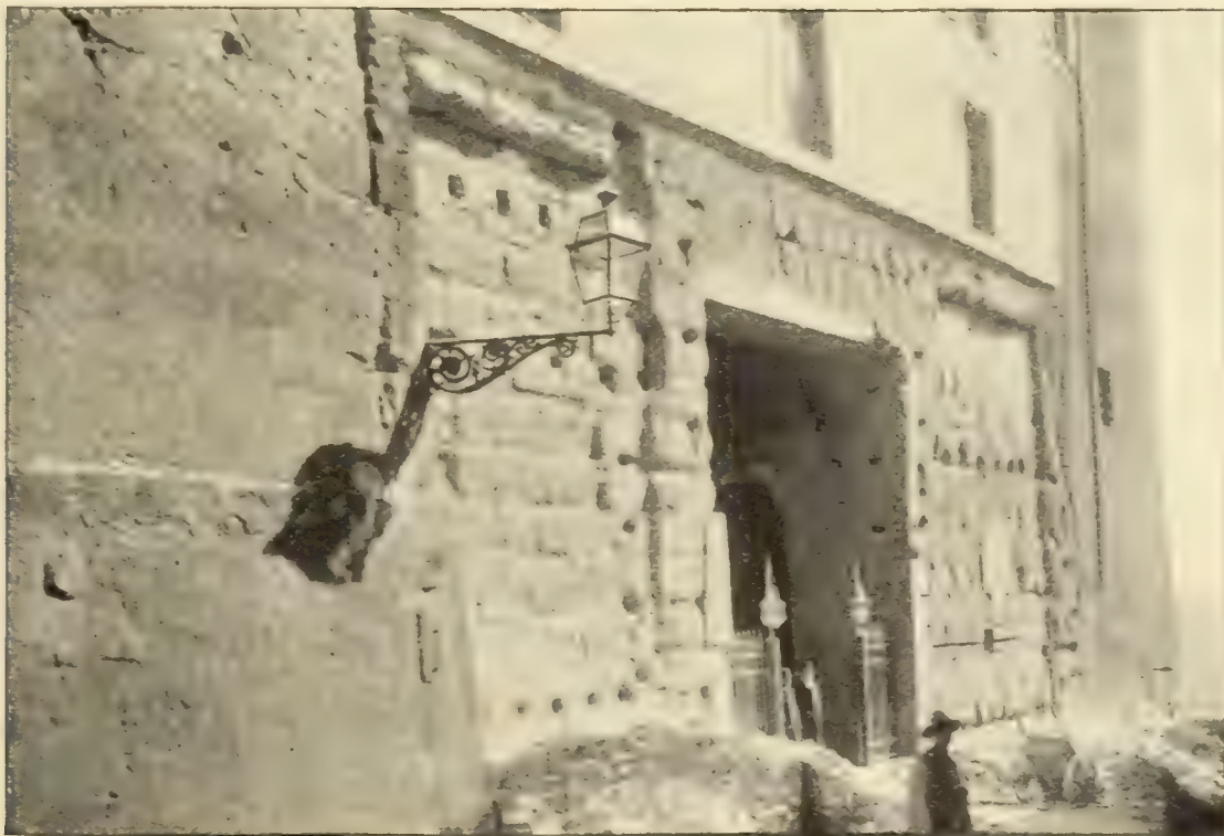
Abbildung 36. Südwestliche Fassade von Westen her, links modern.
